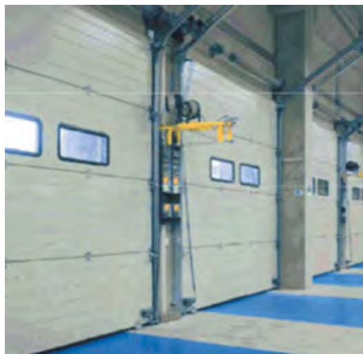
Vista interior muelles de carga
