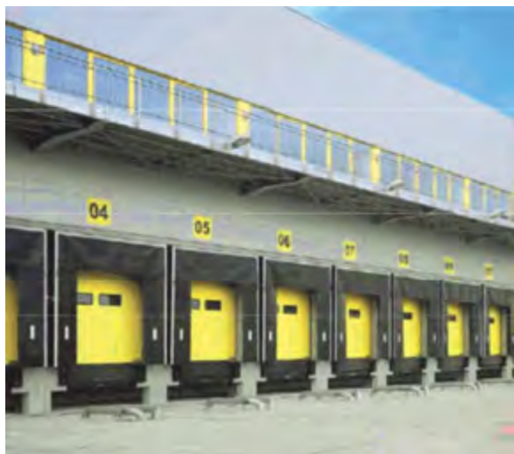
Vista exterior muelles de carga
